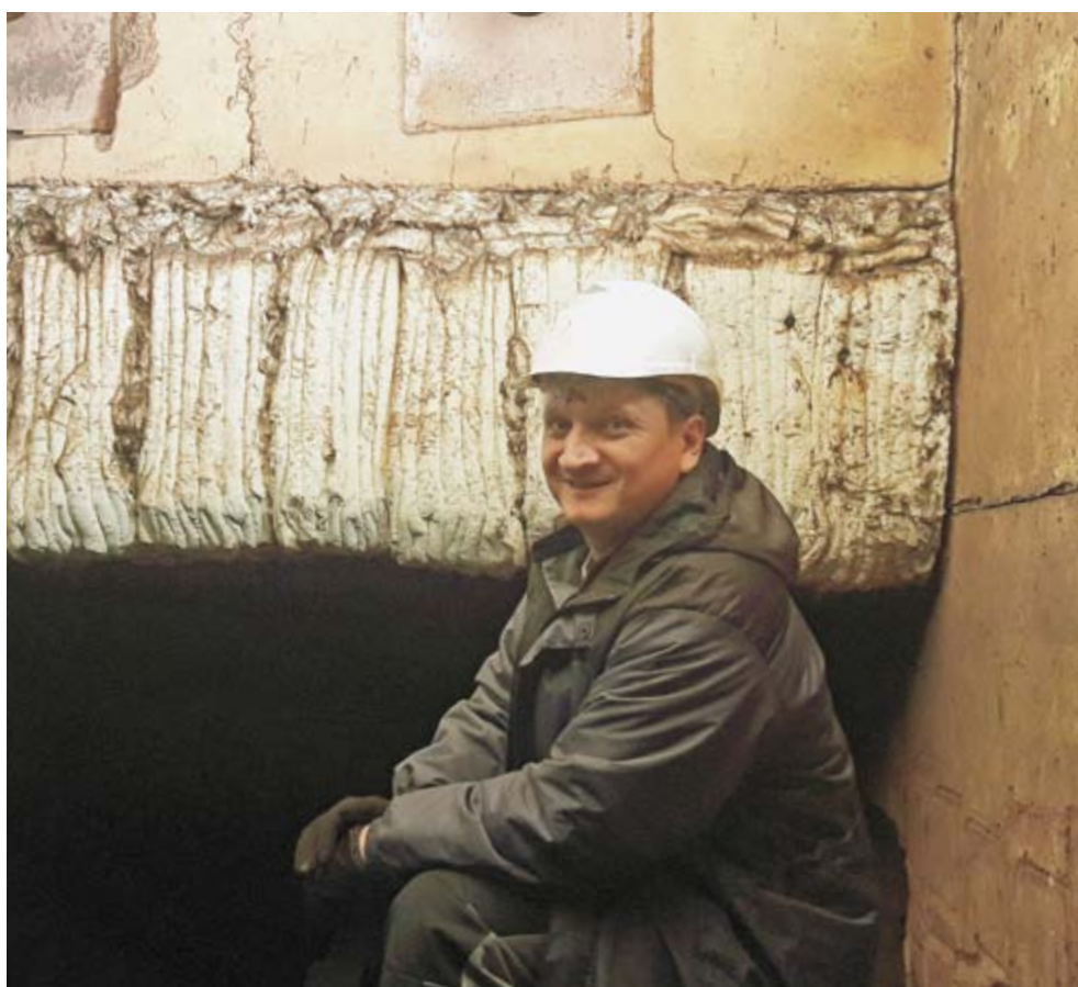
➤ Евгений Прытков, главный инженер ЦРО «Магнезит Монтаж Сервис»
