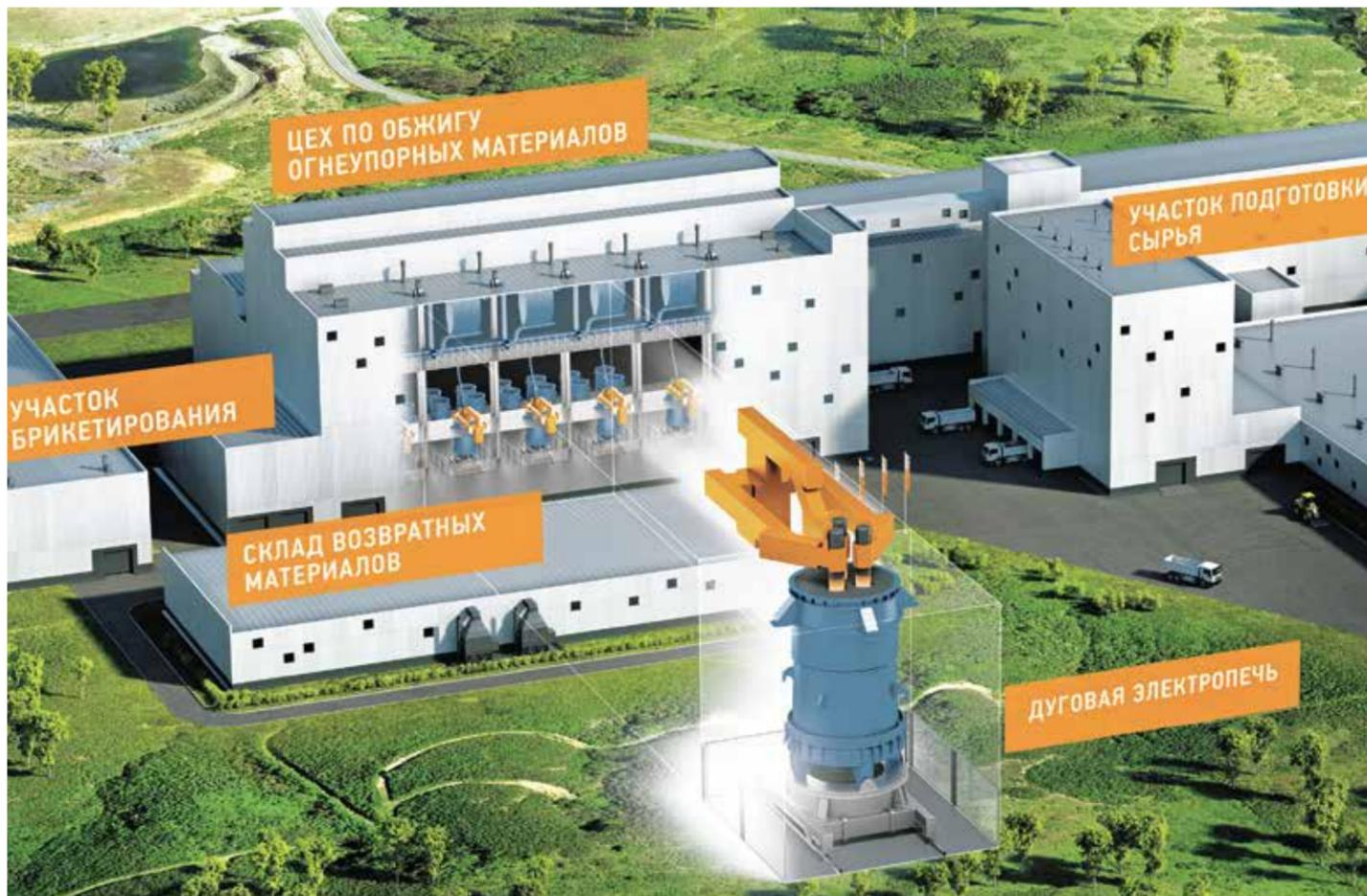
➤ Фрагмент проекта Комплекса по производству плавленного периклаза. Помимо представленных на схеме четырех участков, он будет включать еще один – участок складирования сырья.
