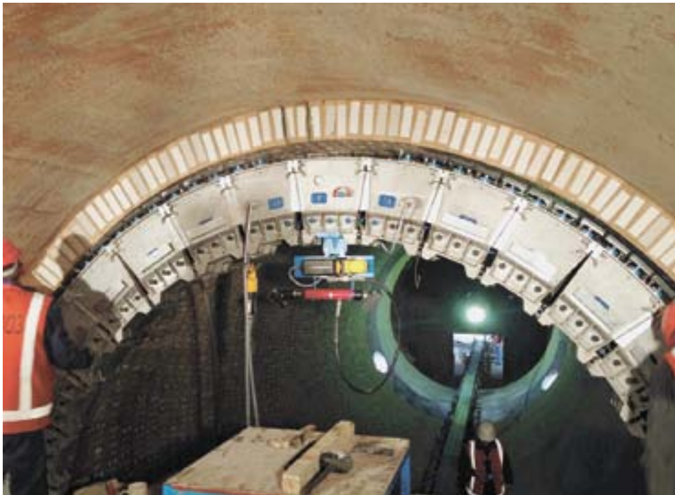
➤ Процесс футеровки печи. Фото предоставлено УИППР
